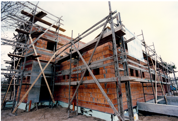
Mit Gerüst baut's besser
